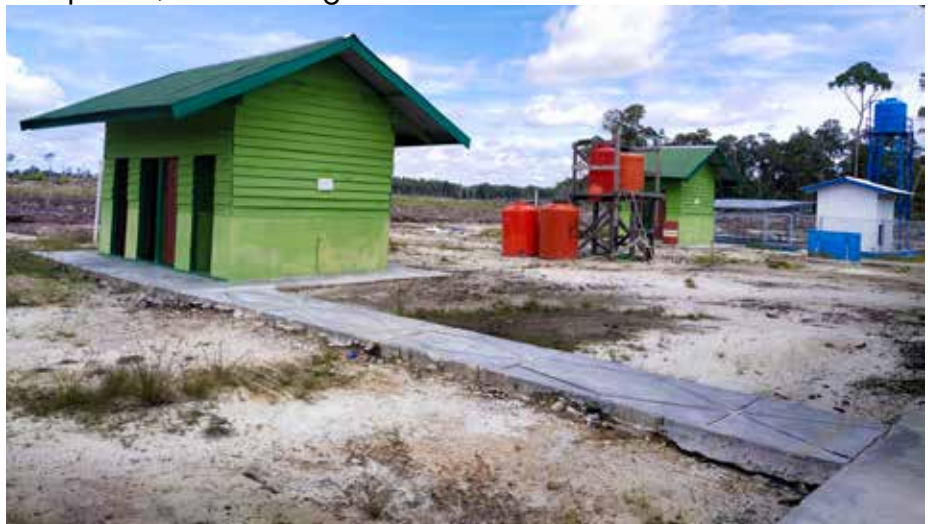
Kondisi bangunan Kamar mandi dan toilet yang ada didalam kawasan food estate/9 Maret 2022/foto BIT
